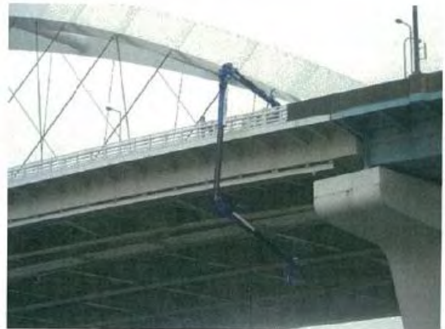
図9 海P100の点検状況（山側より）
