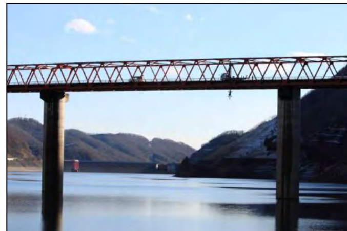
構造が複雑な長大トラス橋、 桁下と水面の間隔が大きい橋梁
