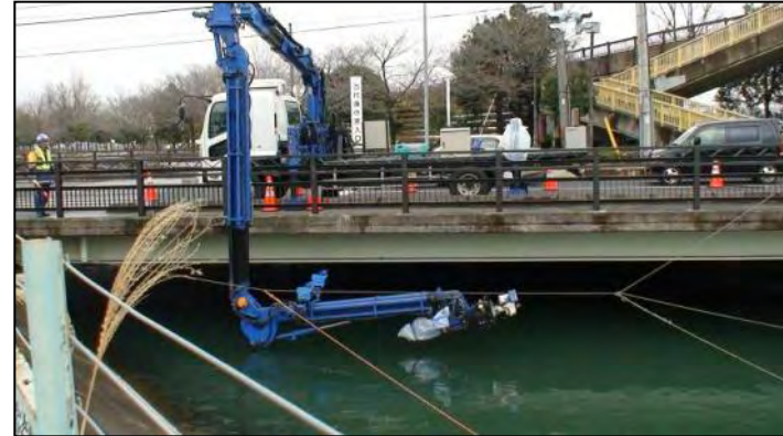
桁下と水面との間隔が小さい橋梁 川の流が速く船での点検は不可
